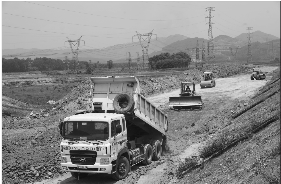
Bộ GTVT và các địa phương có Dự án đường bộ cao tốc Bắc - Nam đi qua đang khẩn trương giải quyết các vướng mắc để đẩy nhanh tiến độ thi công Dự án Ảnh: TTXVN
